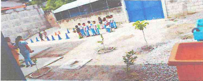
Foto1: Instalación de torta de concreto
